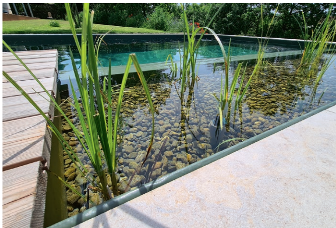
Die Flachwasserzone (linkes Bild) dient nur der Dekoration, um den natürlichen Charakter des Naturpools zu betonen. Gereinigt wird das Wasser in zwei verschiedenen, oberflächlich nicht sichtbaren Kreisläufen.
